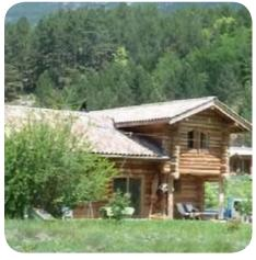
rectitude, mis en oeuvre pas tout à fait secs par un fustier. Six mois sur le chantier suffisent à tailler les bois qui s'empileront tête bêche afin de compenser la conicité des billons. Le séchage s'accélère une fois la maison hors d'eau. Durant 4 à 5 ans on assiste alors au tassement de chaque billon, près de 12 cm au faitage sur la hauteur totale de la maison. Heureusement la conception du fustier prévoit astucieusement ce tassement
